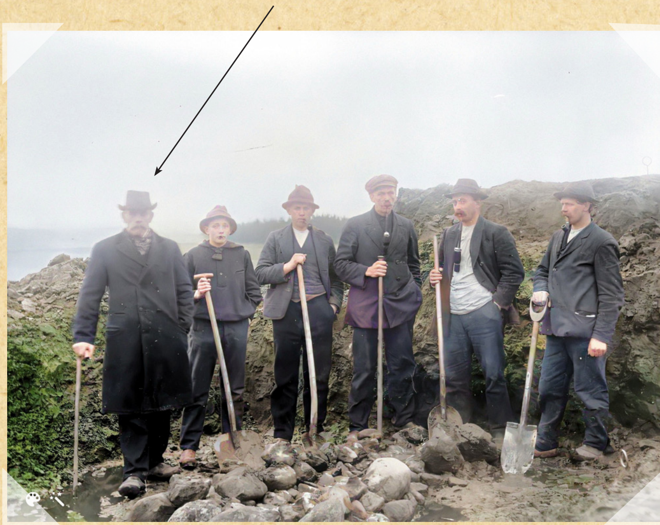
udgravningsholdet ved Storhøj i Egtved.
